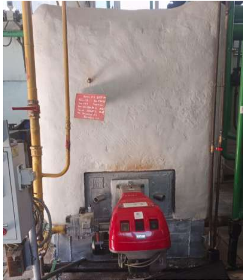
Замена котлов КСГн-1,16 на котельной Жумабаева, 36б
