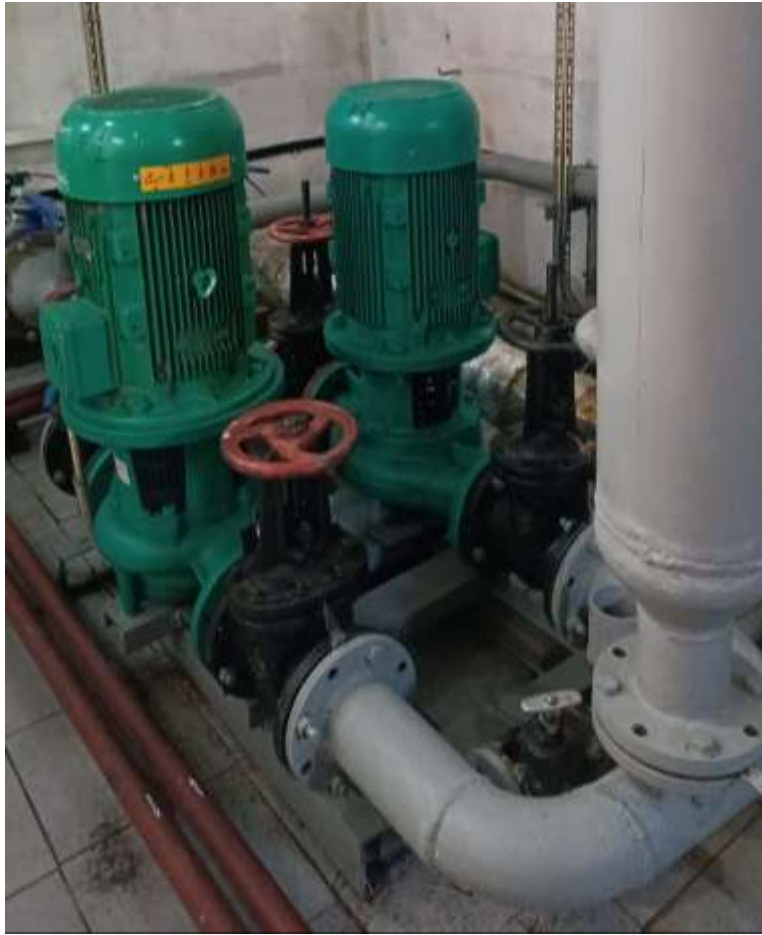
Замена насоса Д320/50 75 кВт на котельной «Школа №80»
