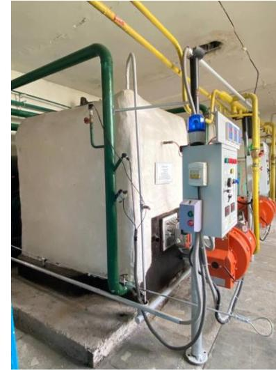
**Замена регулятора давления газа РДБК-50 на регулятор давления РДП-50Н в ГРУ на линии №1 паровых Котлов на котельной Кокжиек**
