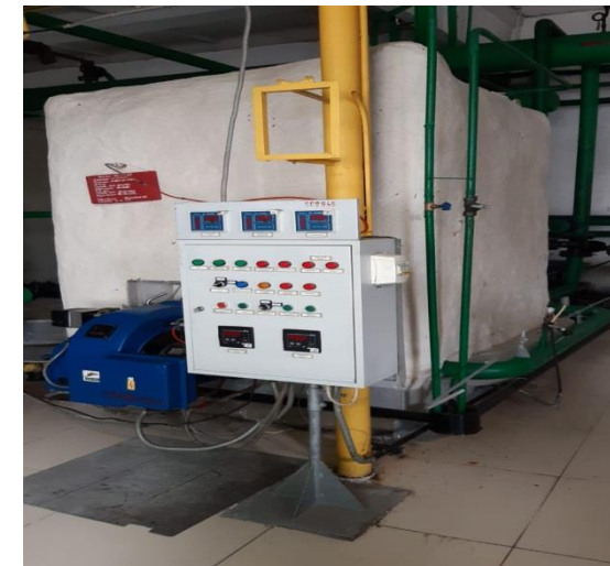
Котельная Сейфуллина 152 Замена котла КСГН-1.16-1 шт
